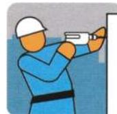
Faça um furo com broca de  $\varnothing$  igual ao  $\varnothing$  externo do chumbador e comprimento indicado.
